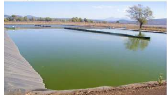
Lagunas de oxidación
