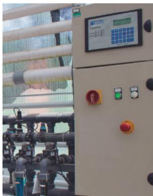
El sistema HI 10000 permite la inyección de 4 (hasta 7) fertilizantes independientes y 1 ácido. El sistema de ácido puede inyectar de forma segura cualquier tipo de ácido y utiliza un algoritmo de última generación que mantiene con precisión el punto de ajuste de pH en una amplia gama de velocidades de flujo.
